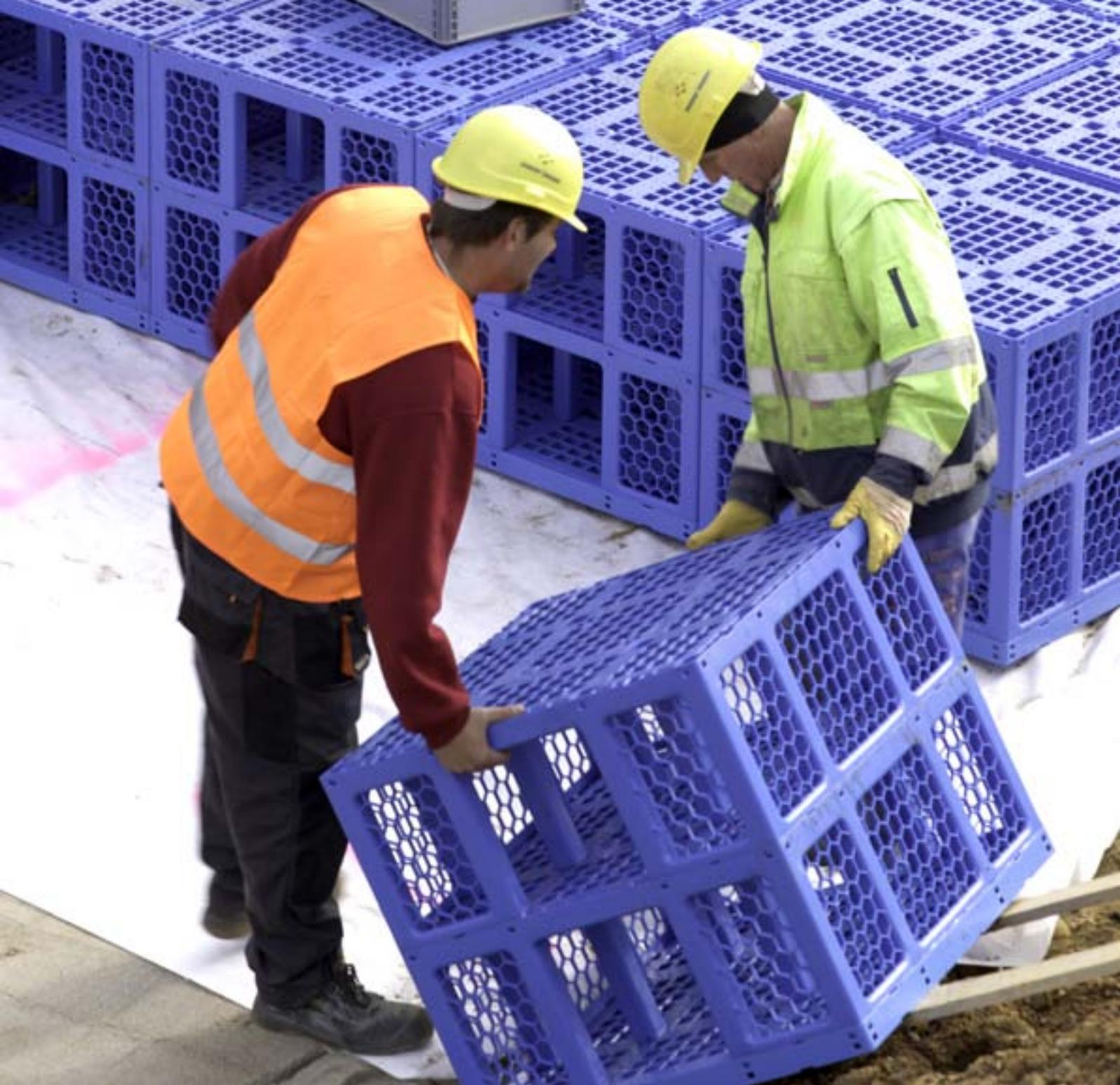
Beim Bau von versiegelten Flächen sind ausreichend dimensionierte Versickerungsanlagen gesetzlich vorgeschrieben. Beim Bau eines Parkplatzes oder einer Straße kann die Wassermenge, die auf die versiegelte Fläche auftritt, dort nicht mehr versickern. Um dies zu kompensieren, muss das zu den Rändern ablaufende Wasser durch entsprechende Zusatzlösungen kontrolliert abgeleitet weiter.
