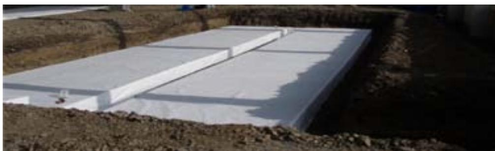
Zum Anschluss von Zulaufleitungen sind ausschließlich die Stirnwandgitter mit den entsprechenden Stirwandadaptern zu verwenden. (siehe Seite 4 „Stirnwandgitter“). Zuläufe sollen i.d.R. an der jeweils höchsten Anschlussmöglichkeit am Rigolenelement erstellt werden. Abläufe hingegen, z.B. für abgedrosselte Ableitungen, werden i.d.R. am tiefsten Punkt angebunden. Zum Anschließen der Rohre wird an der entsprechenden Stelle die Anschlussplatte in die Stirnseite der Rigole eingesetzt.
